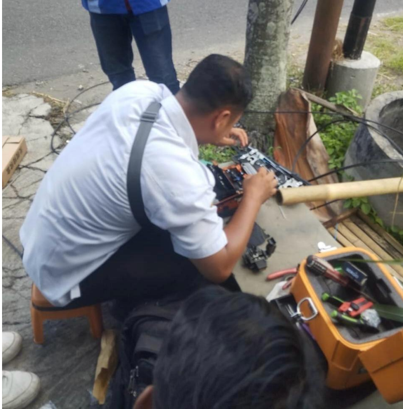
Gambar 2.22 Pengecekan Jaringan Fiber Optic
