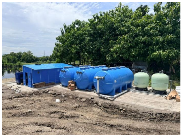
Gambar 2.35 Penanganan sampah dan pengolahan lindi di TPA Troketon
