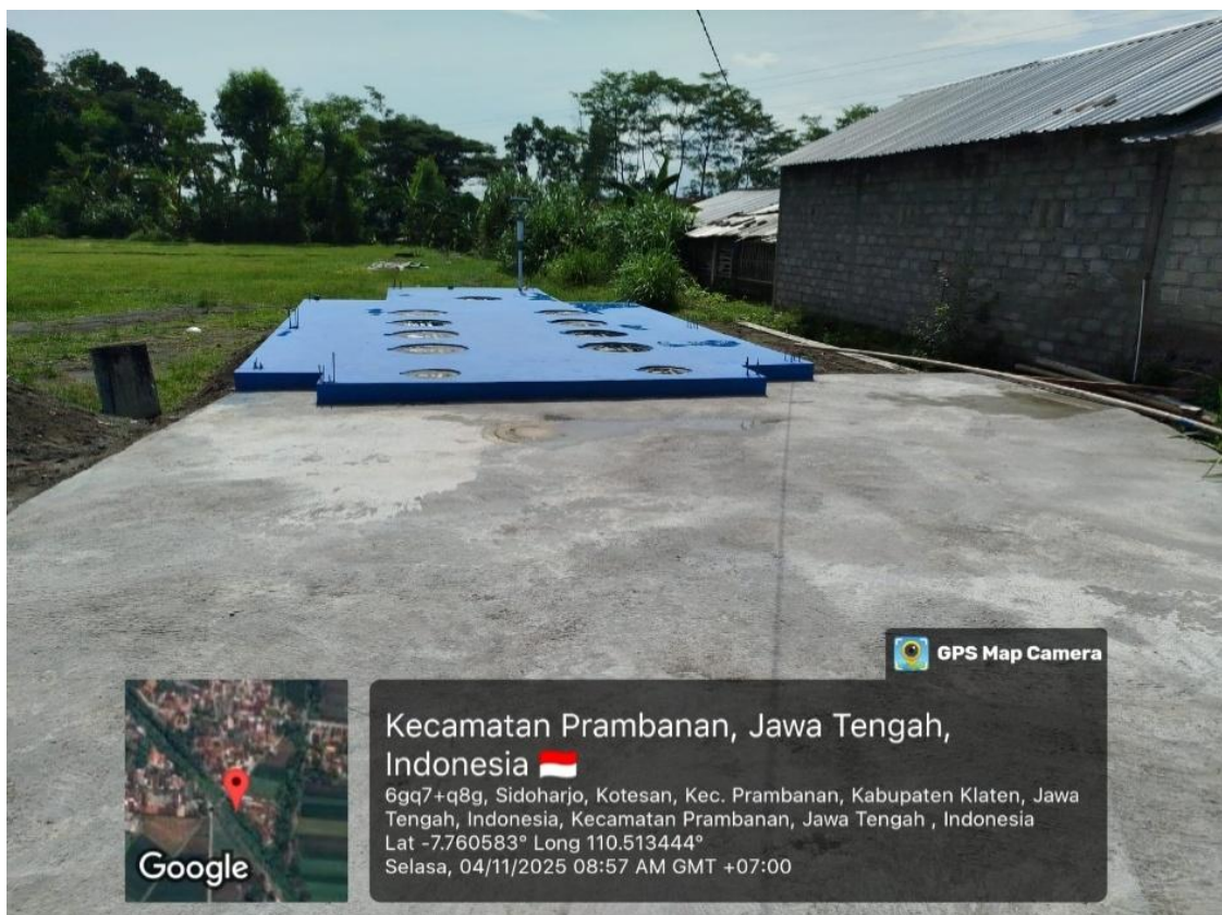
Gambar 2.17 Kegiatan Pembangunan IPAL
