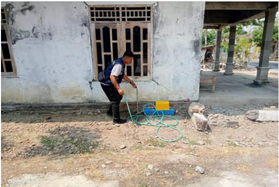
Gambar 2.18 Kegiatan Pembangunan SPAM
