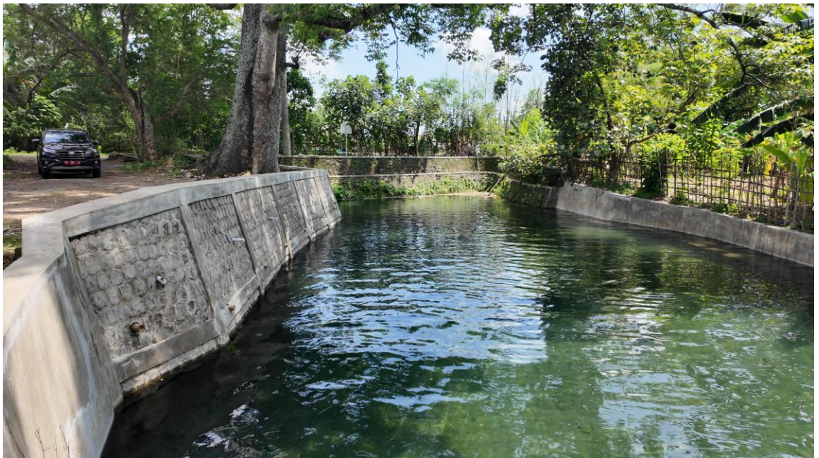
Gambar 2.19 Rehabilitasi Jaringan Irigasi DI. Widoro
